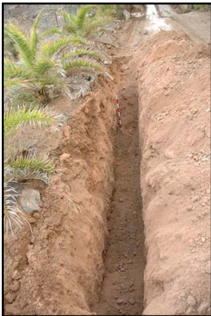
Vista de una de uno de los sectores de la zanja
