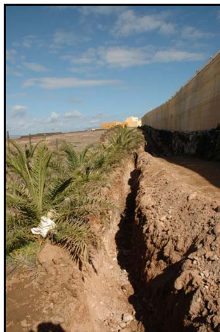
Aspecto de la zanja en el sector Sur del yacimiento
