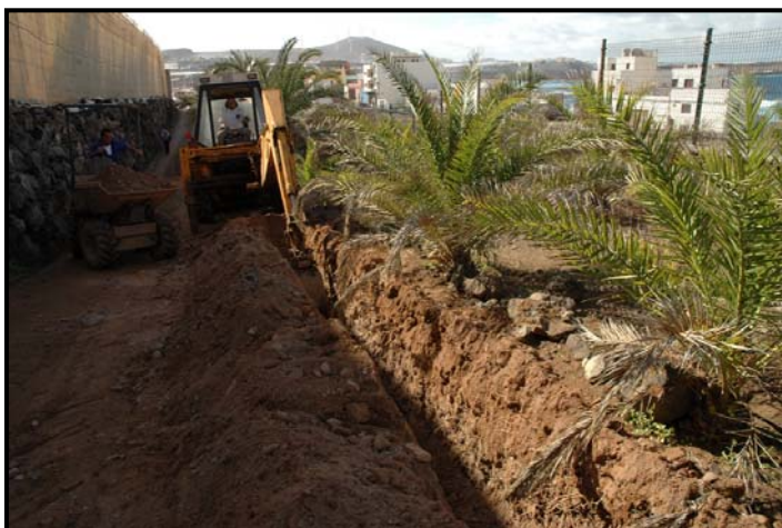
Proceso de apertura de la zanja
