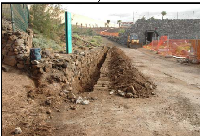
Aspecto de la zanja en el sector Oeste del yacimiento
